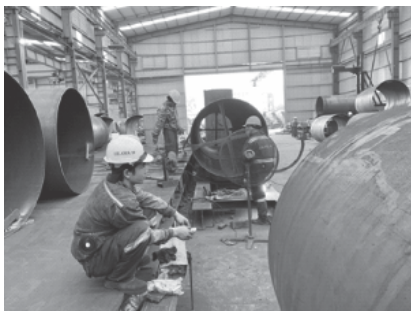
“Kỷ luật – An toàn – Chất lượng – Hiệu quả” - Kim chỉ nam trong mọi hoạt động của LILAMA 10 – từ nhà máy chế tạo đến công trường thi công.
